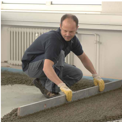
Verlegung des Leichtausgleichsmörtels UZIN NC 194 Turbo
