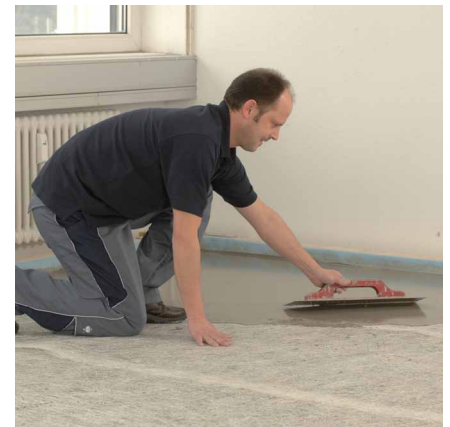
Auftrag der Fliesenspachtelmasse codex FM 50 Turbo
